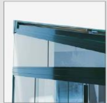
Option Dreieckschluss mit Glashaltefaschen (A) – fast unsichtbar
